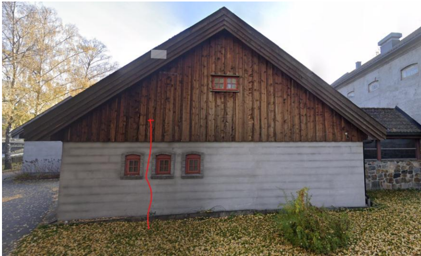
Figur 4. Forslag til Innføring av kulvertrør inn i bygget med industriutstillingen. Rørene føres inn opp langs vegg, og inn i åpne takstoler (innenfor kledningen). Nøyaktig innføring avklares med Bergverksmuseet for eksempel på tilbudsbeifaringen..
